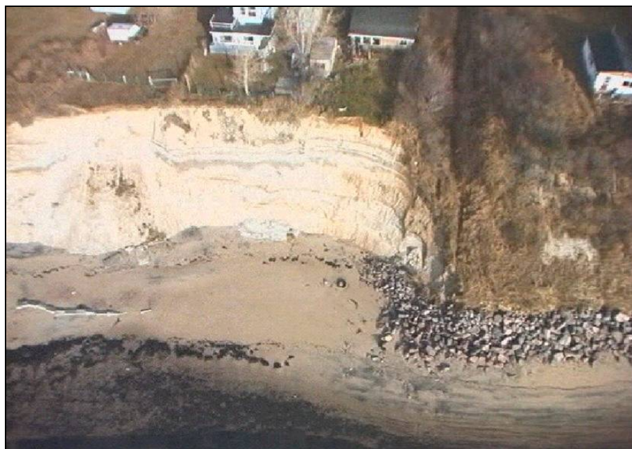
Figure 3 – Travaux d'engrochement et effet de bout (Photo : MSP, 2000)
