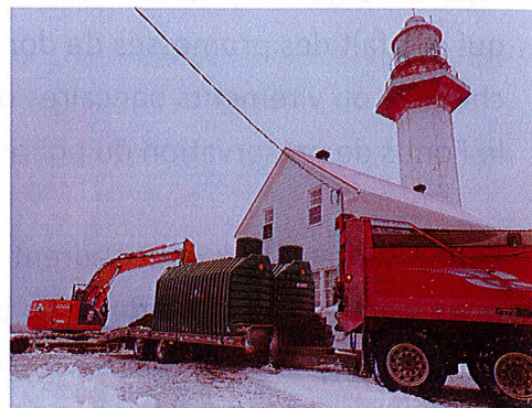
Lors de l'installation des nouveaux systèmes septiques. (Photo : Ladd Johnson)
